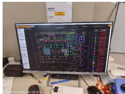
ระบบควบคุมไฟฟ้าส่องสว่าง (2-Wire)
